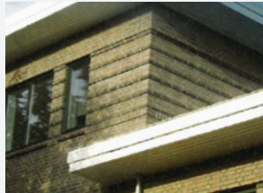
Baksteen met horizontale geleding en detaillering in metsel- en voegwerk
