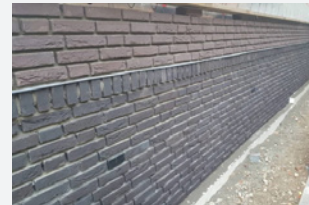
Gebouwplint in donkerdere tint metselwerk afgewerkt met een rollaag.
