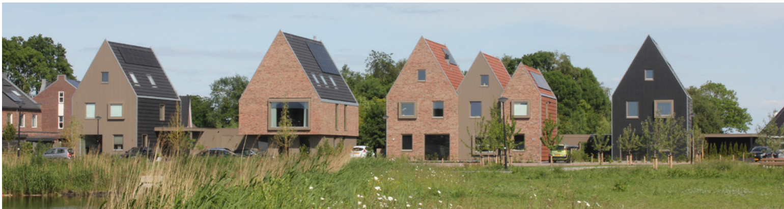
Foto uit De Draai, bouwveld Duizendbladweg
