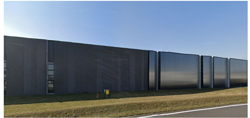
verticale geleding groter bouwwerk (bron: google maps)
