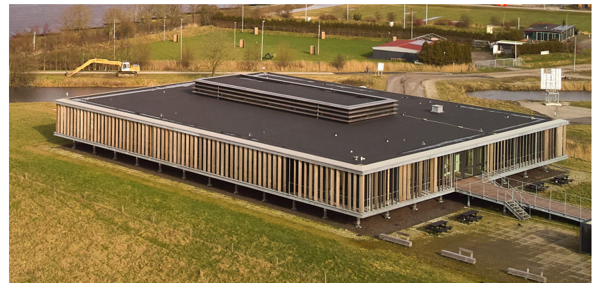
monoliet: een enkelvoudig volume
