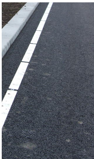
rijbaan asfalt met SMA deklaag Kleur: antraciet / zwart
