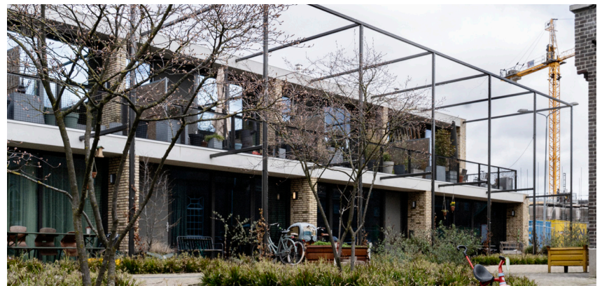
constructies voor groen aan gevels
