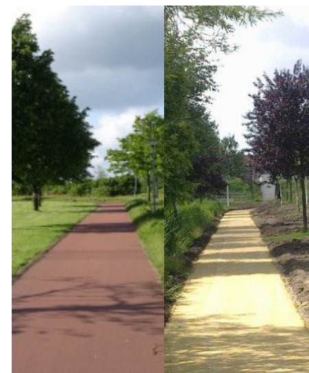
parkzoom fietspad rood asphalt Voetpad halfverharding
